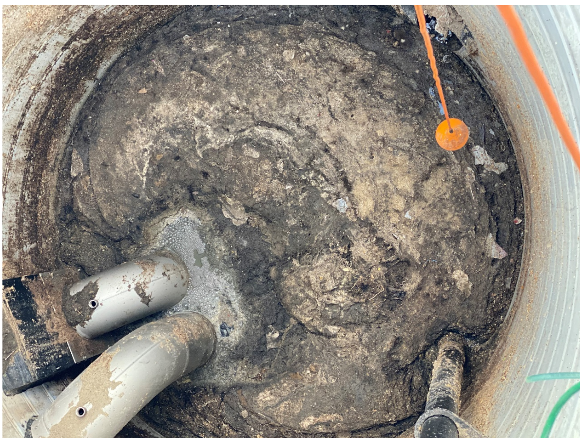
Billede 1: Udpræget flydelag som givetvis forårsager driftsproblemer
