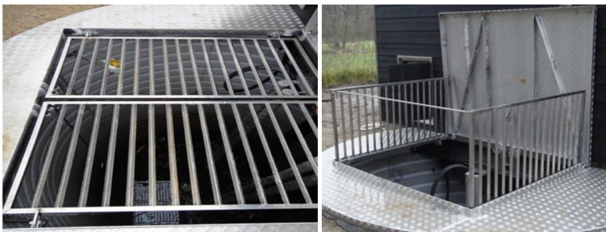
Billede 14: Overfaldet dæksel med sikkerhedsrist
