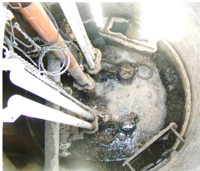
Billede 7: Uvirkosom prelplade, hvor der er luft i sumpmediet
