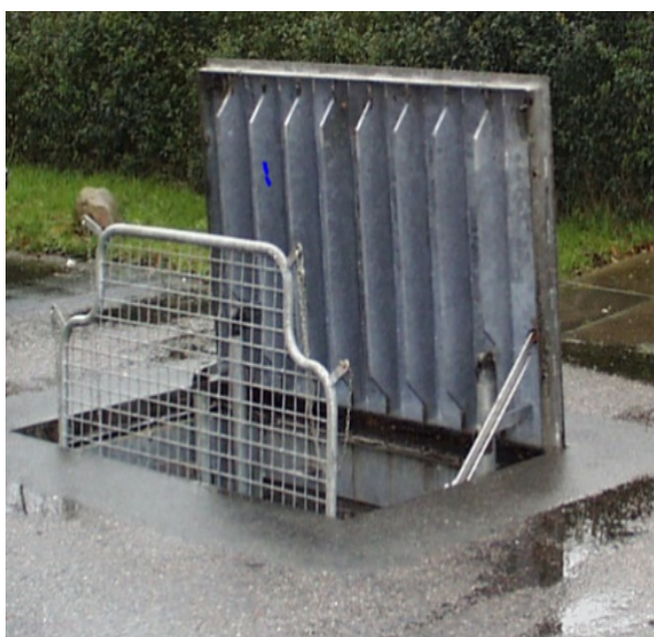
Billede 13: Planforsænket dæksel med sikkerhedsrist
